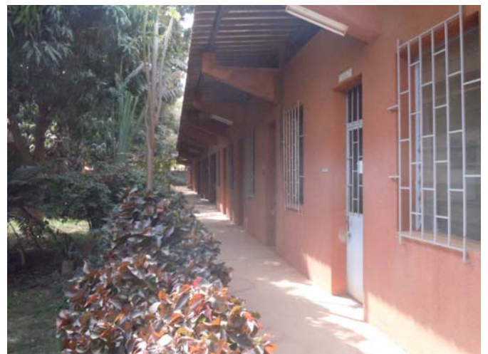
Le chantier est terminé ...
